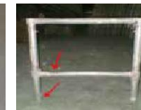
Lommot ja vääristymät
