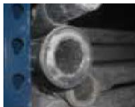
Lommot putken sisällä
